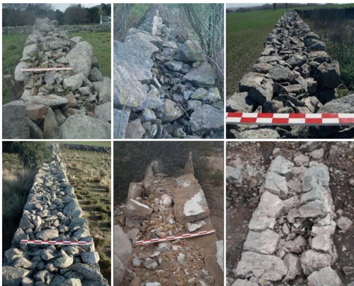
Figura 3. Sistema constructivo denominado “emplecton”. De izquierda a derecha, arriba: Siempre Verde, Corral del Dedo y Los Bosques (todos en Tandilia); abajo: Milla Curá (Tandilia), Fortín Malargüe (Malargüe, Mendoza) y Rossano di Vaglio (Basilicata, Italia). Nótese que a pesar de las diferencias en la materia prima, es notable la similitud en la construcción de los muros.
