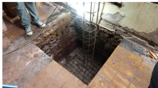
Figura 6. Excavación de la obra en construcción donde se observan las paredes hechas con piedra *itacurú* del antiguo *cotiguazú*.
